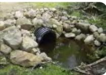
Installer adéquatement le **ponceau** de façon à ne pas limiter la circulation du poisson. De plus, mettre en pratique des mesures de contrôle de l'érosion pour éviter le colmatage des frayères.
