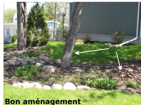
Eau de la gouttière dirigée vers un milieu perméable (jardin de pluie qui laisse s'infiltrer l'eau dans le sol).
