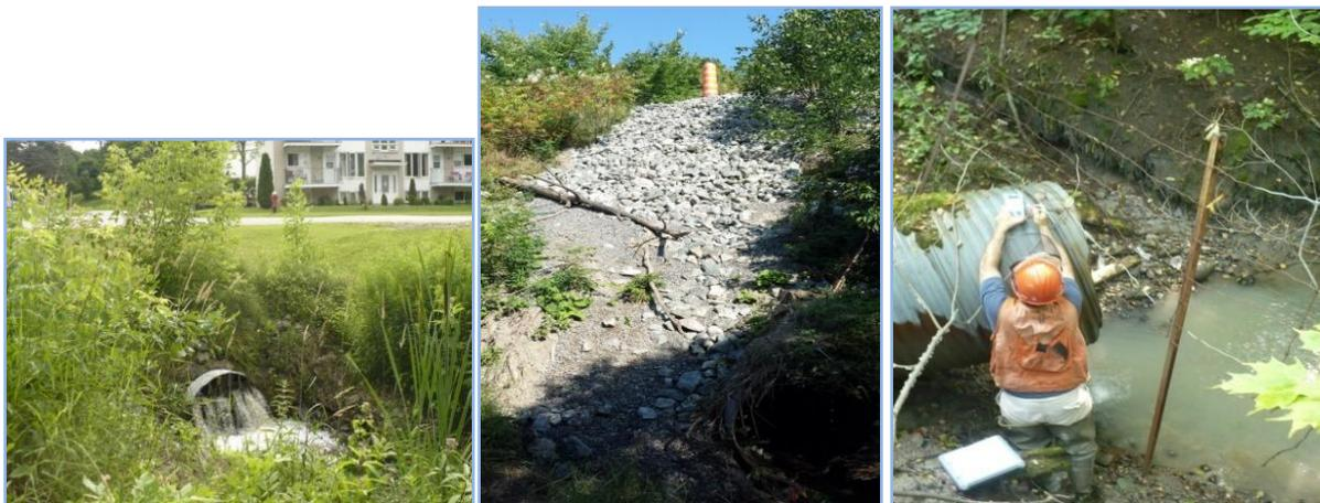
Figure 3.9. Ponceau obstrué et deux ponceaux générant beaucoup d'érosion. Au centre, un glissement de terrain stabilisé temporairement par un enrochement inefficace. À droite, noter les piquets qui ne touchent plus au sol.
