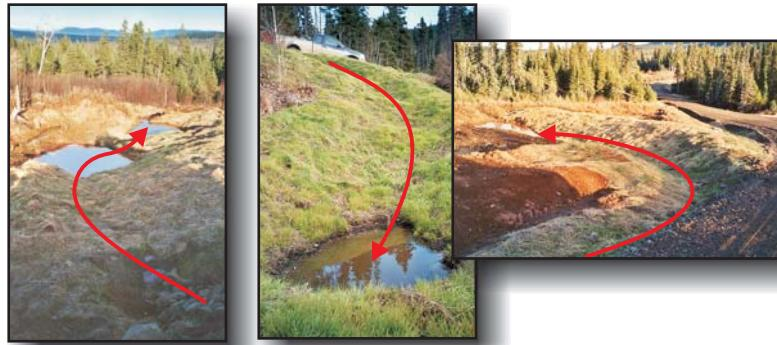
**NOTE :** Afin d'éviter l'érosion des infrastructures de détournement (canal, bassin), la pente des talus des remblais et déblais doit être égale ou inférieure à 1,5 H : 1,0 V et le sol minéral dénudé doit être stabilisé. Pour la stabilisation, nous recommandons d'ensemencer avec le mélange «B» (2kg/50 m<sup>2</sup>) et de l'avoine (2kg/50 m<sup>2</sup>) et de recouvrir d'un paillis de foin non tassé d'environ 8 cm d'épaisseur. Cette technique donne de bons résultats en Gaspésie.
