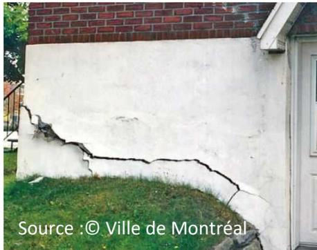
**Figure 20. Fissures dans la fondation d'une habitation sur des argiles sensibles (Montréal)**
