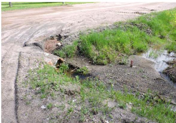
**Figure 25.** Ponceau écrasé et sédimentation, Saint-Aimé-du-Lac-des-Îles. Photo : COBALI.
