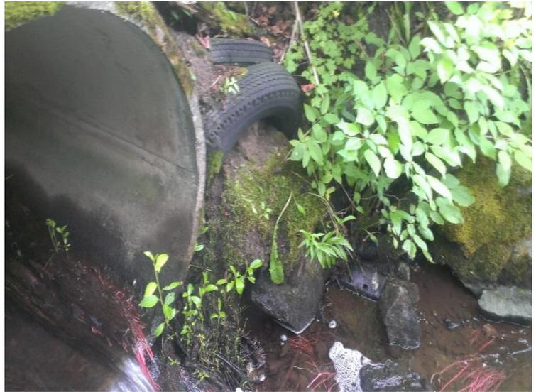
En haut à gauche : Ponceau de la route 117. En haut à droite : remblai de pneus et ponceau privé causant une chute. En bas, le regard pluvial de la route 117 se déverse dans un étang adjacent. Malgré un petit bassin de sédimentation qui devrait être nettoyé, une très grande quantité de sédiments se dépose dans l'étang.
