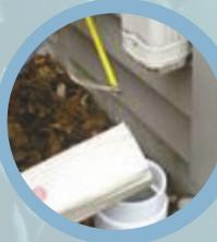
Débranchez la descente de gouttière du drain de fondation.
