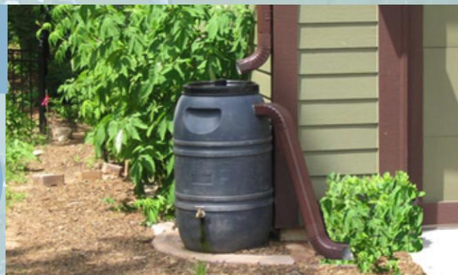
*Ne pas laisser l'eau du baril déborder! Il est important d'utiliser l'eau accumulée. Un tuyau peut être installé dans le haut du baril, permettant de vider le trop plein.*
