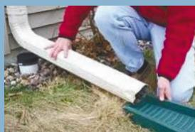
Ajoutez une fin de gouttière qui dirige l'eau, avec un déflecteur, sur une surface perméable.
