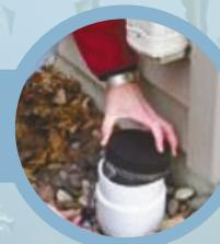
*Le drain de fondation est un conduit souterrain qui récupère l'eau des gouttières pour la déverser directement dans l'égout municipal*
