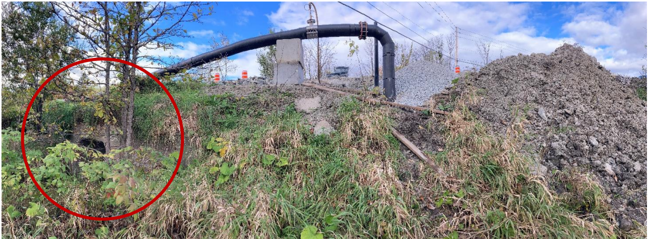
Figure 40. Photo du ruisseau Joanisse (exutoire du ponceau encerclé en rouge) lors de travaux de voirie à la hauteur de la canalisation du ruisseau sous la route 148. COBALI, 2023.
