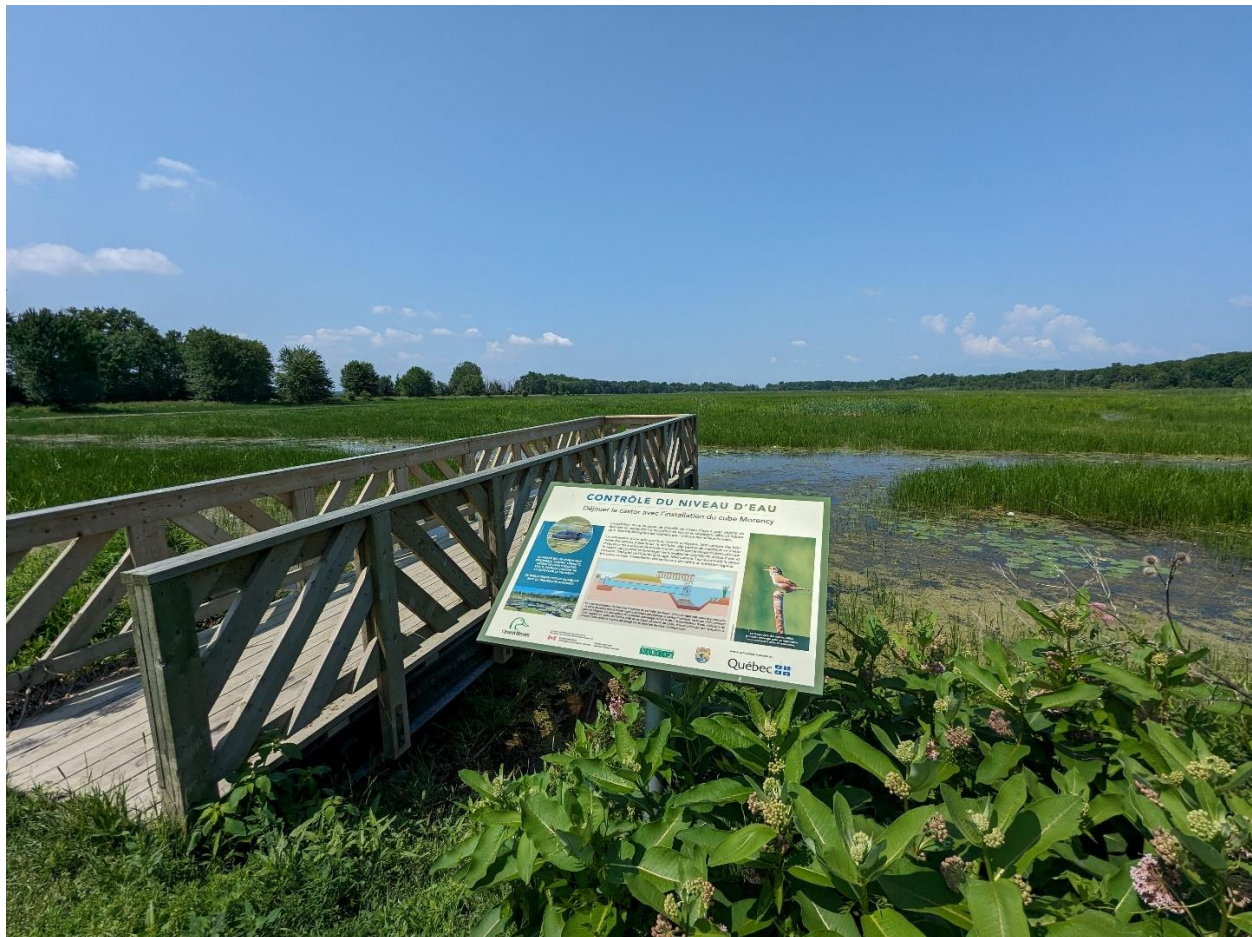
Figure 21. Plateforme d'observation et panneau d'interprétation vis-à-vis la structure de contrôle du niveau de l'eau du marais aux Grenouillettes. COBALI, 2023.
