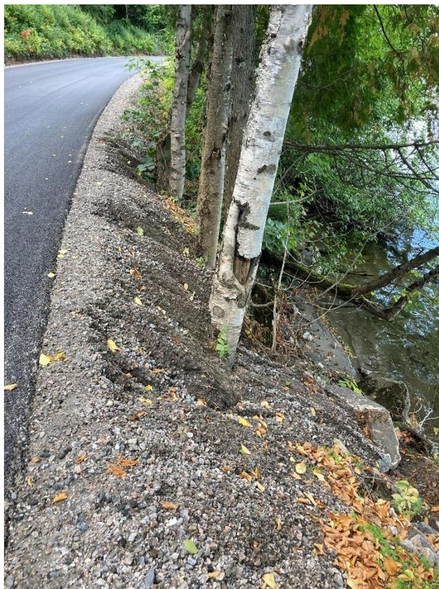
Figure 20. Érosion provenant de travaux récents - 2023
