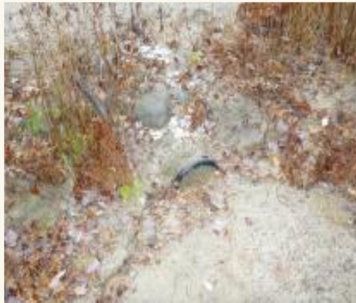
Ponceau de drainage bloqué
