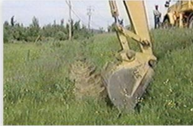
Découpage de la tourbe au point de contact entre le tiers inférieur et les deux tiers supérieurs.
