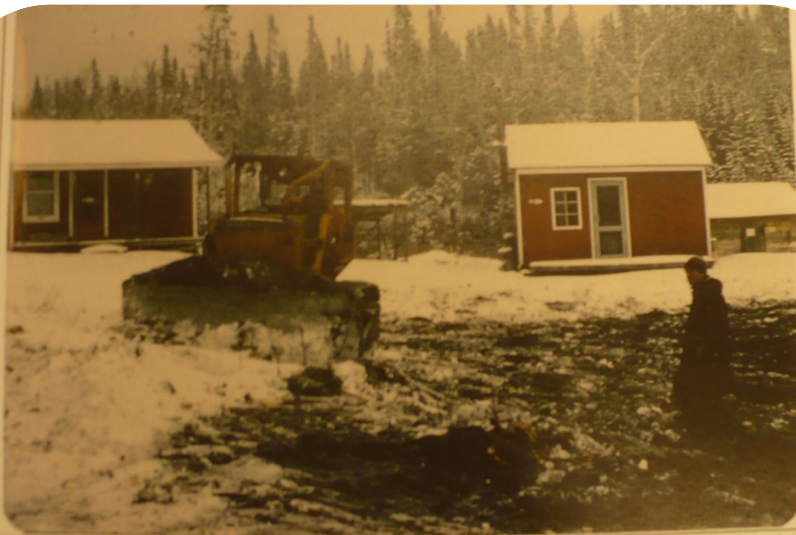
Le blier parvient au lac Huard. On en profite pour dblayer en avant des camps. Le chemin est loin d'tre termin et sera poursuivi au printemps.
