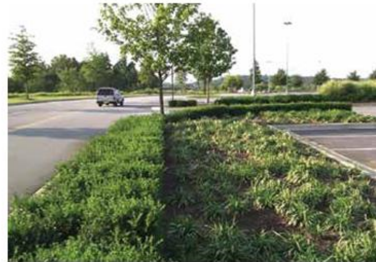
Figure 4.16 Zones de traitement pour un stationnement.
