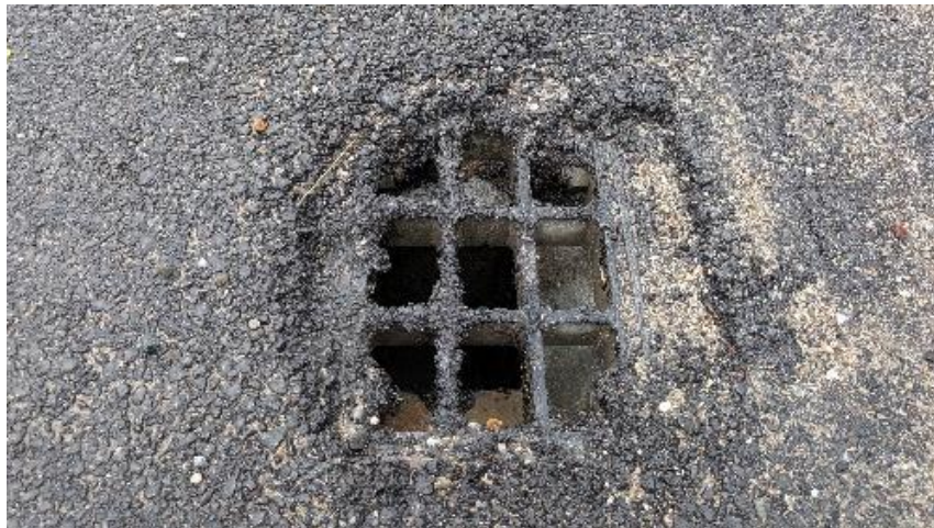
Figure 12. Grilles de drainage, pont de la route 309 – N.-D de la Salette
