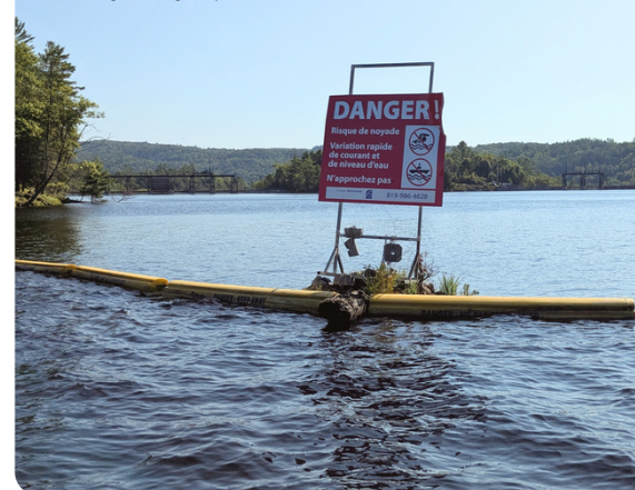
ESTACADE EN AMONT DU BARRAGE HIGH FALLS
